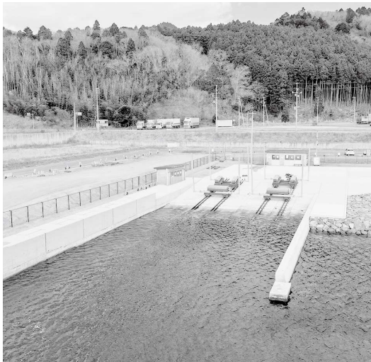
石浜小型漁船船揚場改修工事完成
