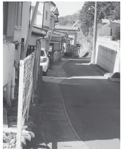
町道浦宿17号線拡幅計画現状
