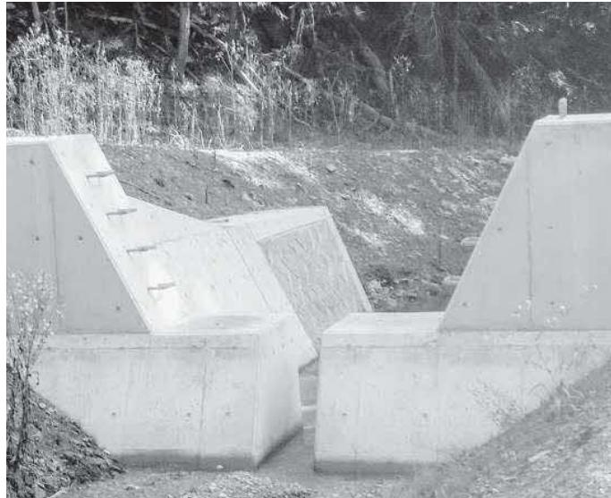
砂防えん堤設置で土砂災害対策を
