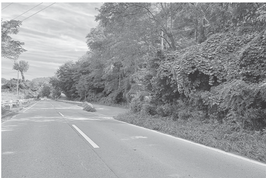
入口に誘導看板の設置を
