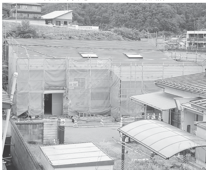
完成へ向け急ピッチの上二区集会所
