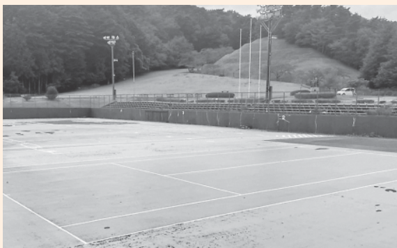
総合運動場内施設修繕事業 291万円
