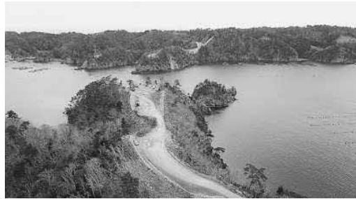
工事が進み出島も目前に
