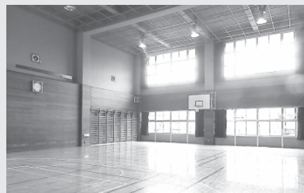
各施設が改修工事で整備されます
