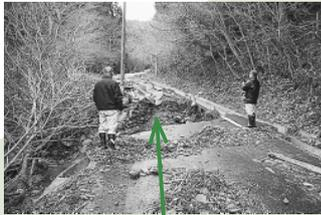
川が氾濫し路面崩壊、3箇所被災した中で一番大きな崩落箇所。
