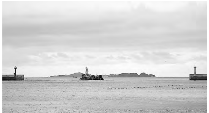
完成した灯台を通る復興作業台船
