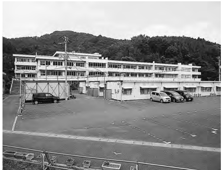
整備起点となる旧一小校舎と校庭
