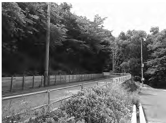
拡幅工事が急がれる野々浜小積道路
