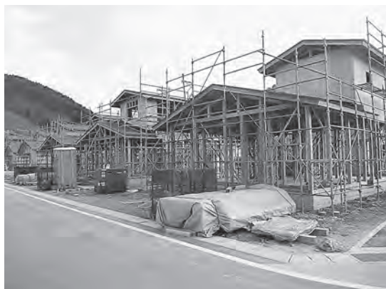
建設が進む西区災害公営住宅
