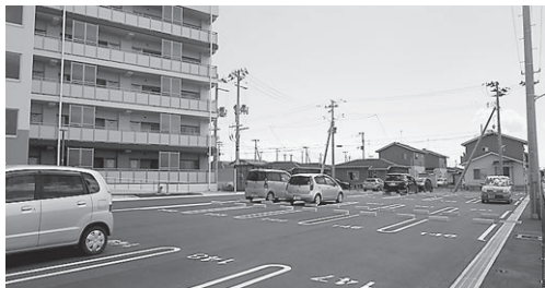
1台目駐車料は無料です (東松島市あおい地区災害公営住宅)
