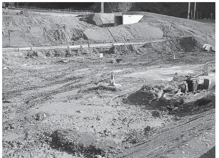
未整備の不沈池（槽）（石浜高台入口）
