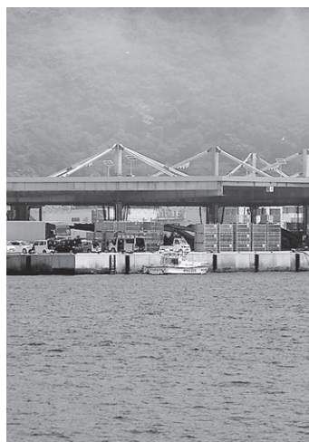
鉄骨梁のプレートを補強 (市場東荷捌場)
