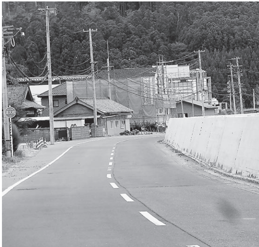
道路かさ上げ最大65センチメートルに (針浜工区)
