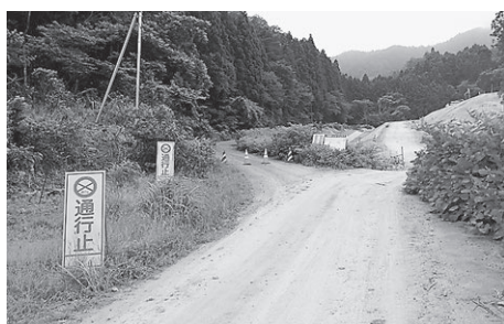
御前地区造成工事中、御前林道 拡幅を
