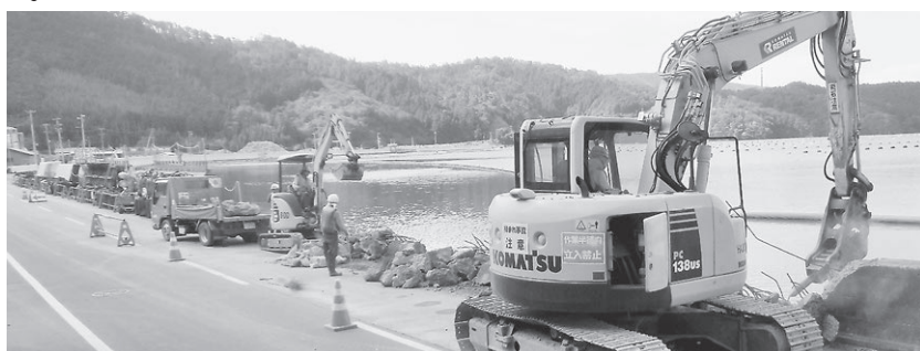
護岸の高上げ工事中（針浜冠水対策）
