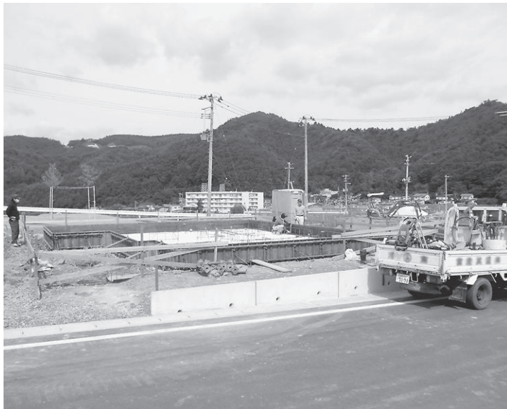
建設が始まる荒立西住宅団地
