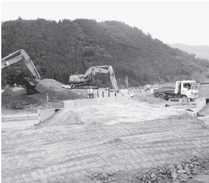
完成間近の高台造成地（荒立西）
