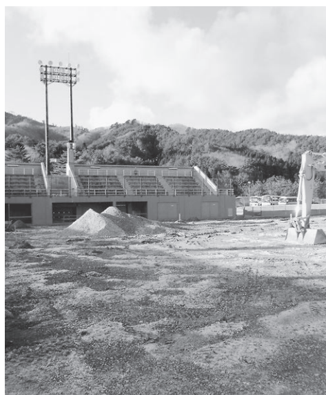
全面が人工芝化される第二多目的運動場
