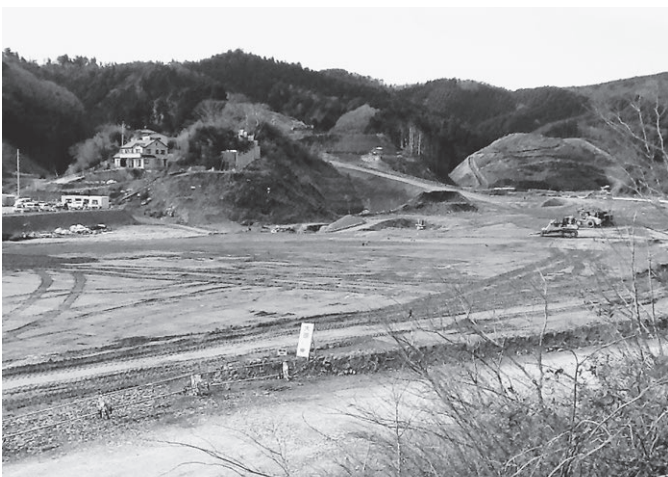
順調に進む女川駅工事、17年3月オープン
