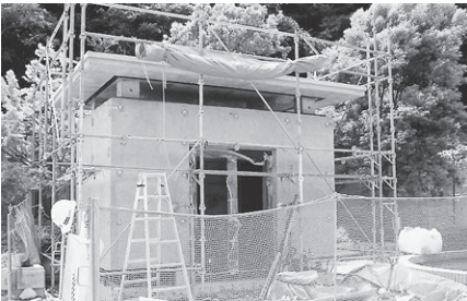
工事中の納骨堂
