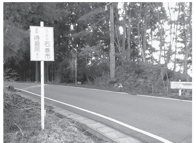
猪落から屋敷浜線拡幅工事の完成を急げ
