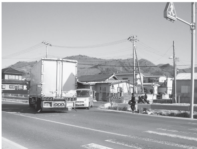
事故多発の浦宿踏切付近
