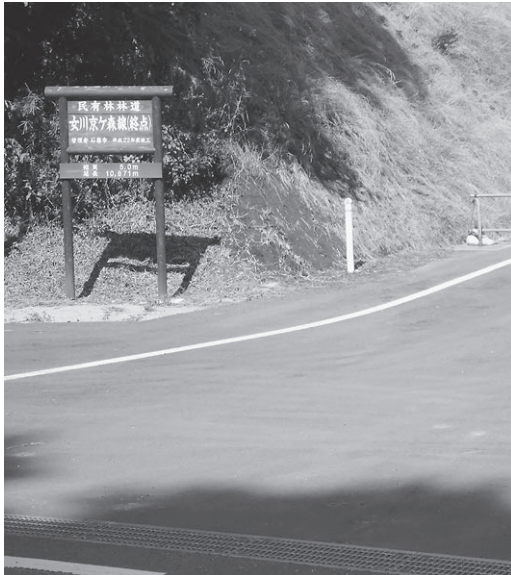
石巻工区完成部分と大沢林道への取付道
