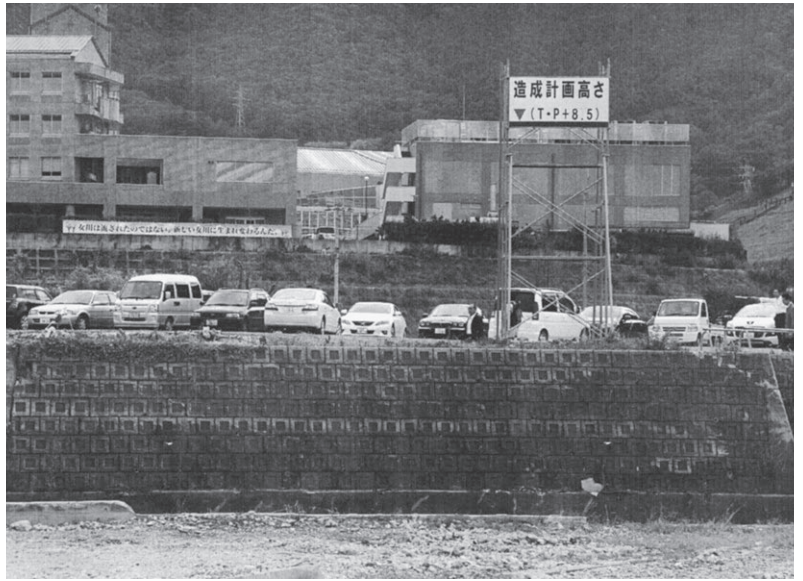
町中での盛土が始まりました
