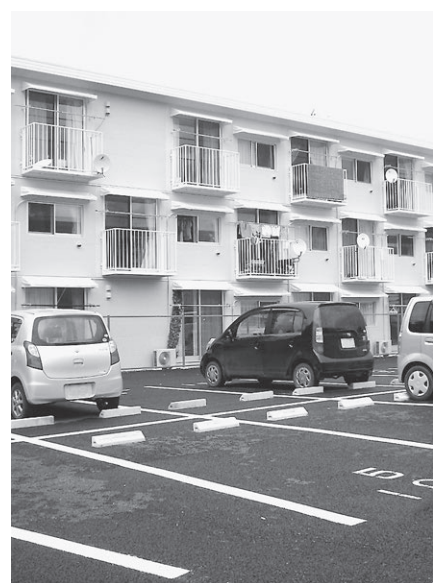
全国初3階建て仮設住宅
