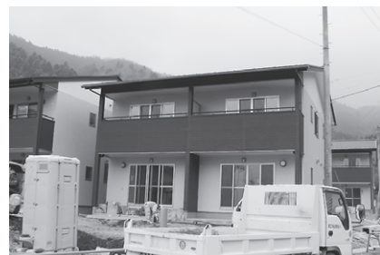
外構工事が進む浦宿第一住宅
