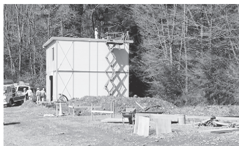
仮設消防署建設現場
