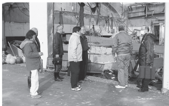
東卸売場解体現場
