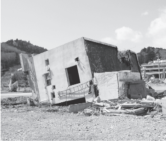
倒壊したビルだけ目立つ海岸地域
