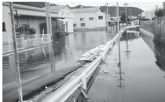
地盤沈下・浸水対策を早急に
